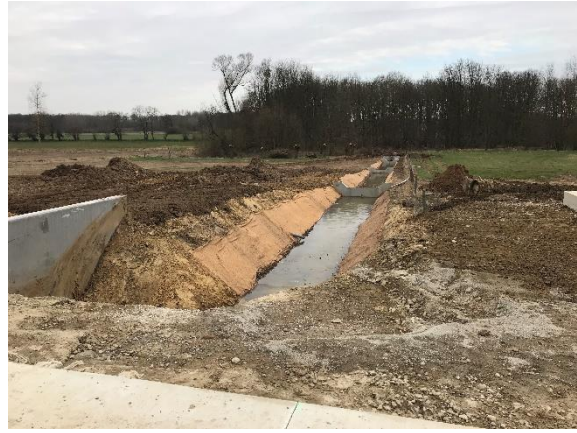
Foto 2.9.1.5-1: Constructies t.h.v. Diestsestraat
