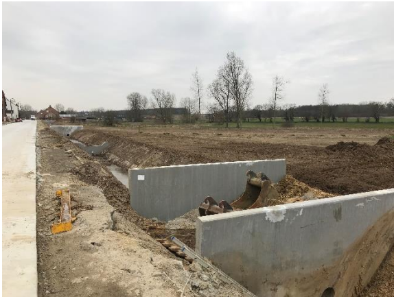
Foto 2.9.1.5-2: Constructies t.h.v. Diestsestraat
