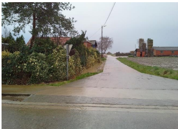
Foto 2.9.4.12-1: Wateroverlast t.h.v. Schansstraat
