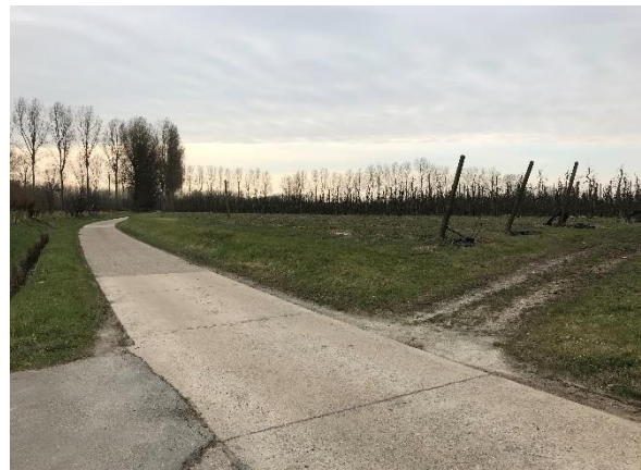
Foto 2.9.6.2-1: Hoek Kapelstraat - Groothuisstraat
