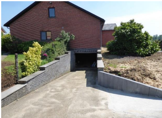
Foto 2.9.3.5-3: Toegang naar ondergrondse kelder
