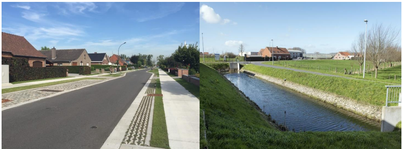
Figuur 35: Links: Lokale infiltratie wegverharding en fietspad. Rechts: Infiltratiebekken
