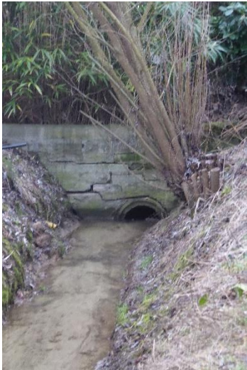
Foto 2.9.5.9-1: Doorsteek achter Linderstraat 12
