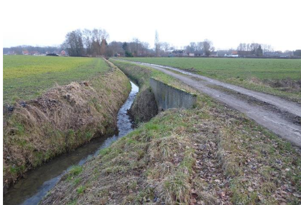
Foto 2.9.5.10-2: Uitstroom t.h.v. Pompstation
