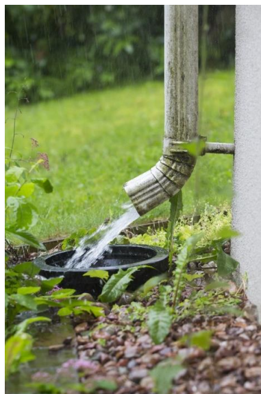
Figuur 33: Afkoppelen dakafvoer van het afvoerstelsel
